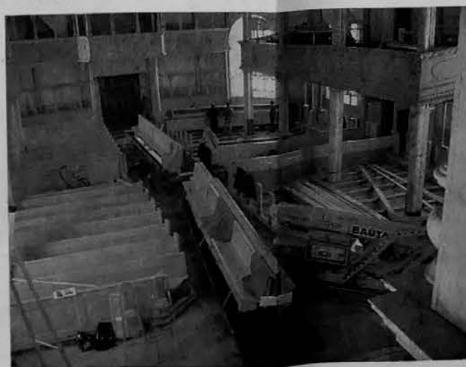
Skanting av tømmer som skal brukes til lafting. Bildet er tatt under et laftekurs i regi av Rørosmuseum, Røros kommune og Utbusprosjektet og Røros Ressurs. (Foto Rørosmuseum)
