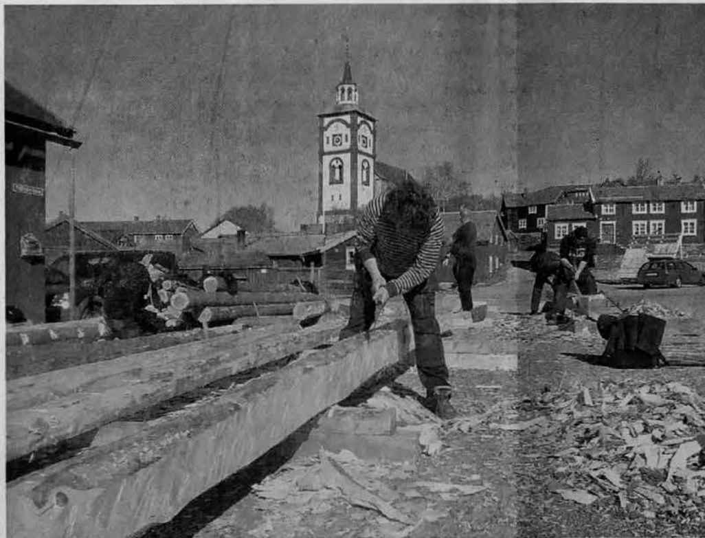
Skanting av tømmer som skal brukes til lafting. Bildet er tatt under et laftekurs i regi av Rørosmuseum, Røros kommune og Utbusprosjektet og Røros Ressurs. (Foto Rørosmuseum)
