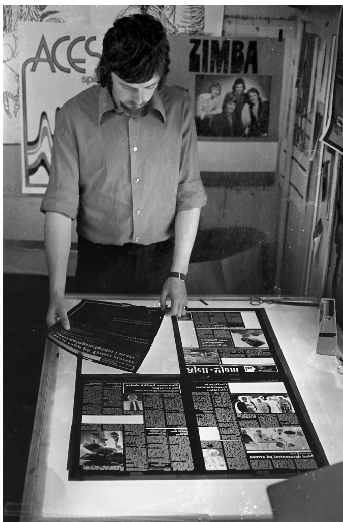
Odd Gullikstad monterer sidefilmene sammen før de legges i platebrenneren.
